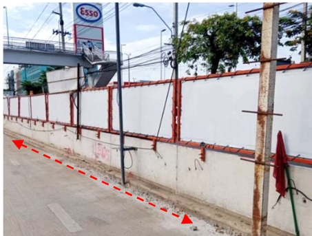
รูปที่ 16 การยาแนวตามรอยต่อและฐานของแบรีเออร์
