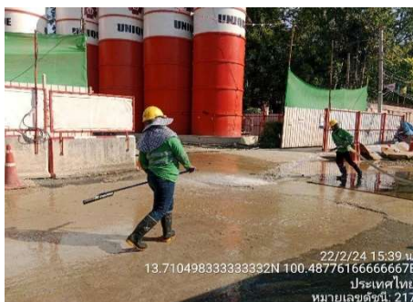
รูปที่ 11 ฉีดพรมน้ำภายในพื้นที่ก่อสร้างและเปิดสเปรย์ละอองน้ำ
