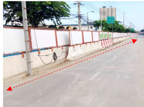
รูปที่ 16 การยาแนวตามรอยต่อและฐานของแบรีเออร์
