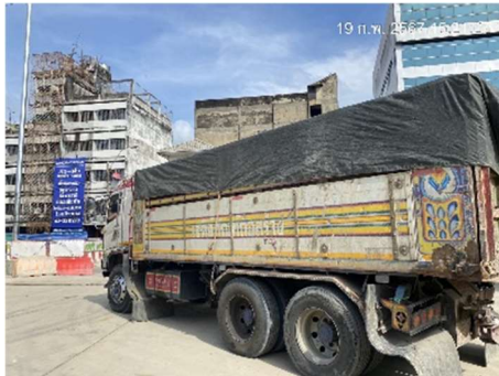
รูปที่ 10 ปิดคลุมผ้าใบกระบะรถบรรทุกขนดินให้มิดชิดก่อนออกจากพื้นที่ก่อสร้าง
