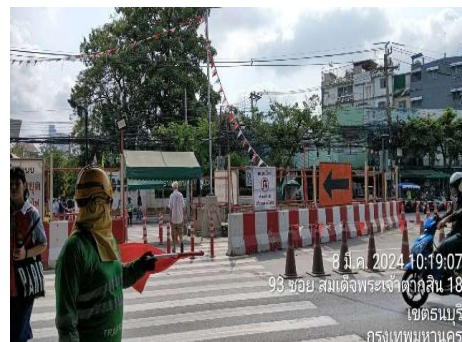
รูปที่ 13 ติดตั้งป้ายเตือนและสัญลักษณ์จราจรต่างๆ
