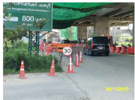
การติดตั้งสัญญาณป้ายเบี่ยงช่องทางจราจร
