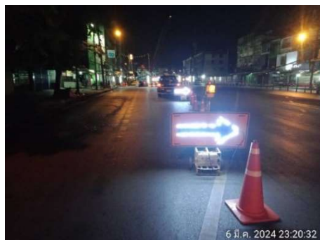
รูปที่ 13 ติดตั้งป้ายเตือนและสัญลักษณ์จราจรต่างๆ
