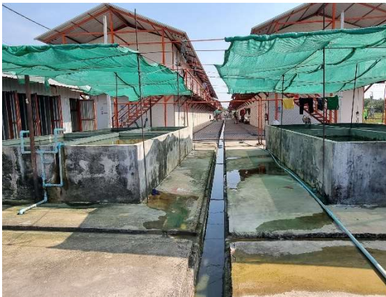
รูปที่ 2-10 รางระบายน้ำและระบบบำบัดน้ำเสียบริเวณบ้านพักคนงาน
