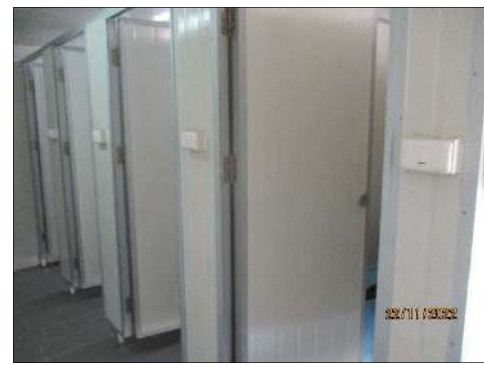
ระบบสุขาภิบาลเป็นรูปแบบ Mobile Toilet Container
