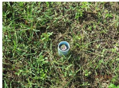
รูปที่ 2-3 ระบบรดน้ำต้นไม้ (Sprinkler)
