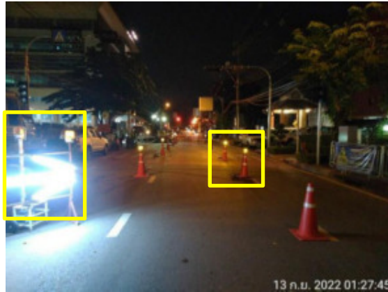
รูปที่ 2-31 การติดตั้งป้ายเตือน พร้อมทั้งไฟกระพริบและกรวย ที่ระยะ 20 เมตร (ต่อ)
