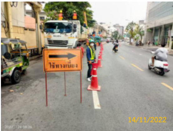
รูปที่ 2-23 การติดตั้งไฟบนแนวพื้นที่ก่อสร้าง และป้ายลูกศรไฟเบี่ยงจราจร
