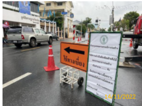
รูปที่ 2-23 การติดตั้งไฟบนแนวพื้นที่ก่อสร้าง และป้ายลูกศรไฟเบี่ยงจราจร
