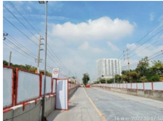
รูปที่ 2-11 การติดตั้งรั้วที่ความสูงอย่างน้อย 2 เมตร ตลอดแนวพื้นที่ก่อสร้าง
