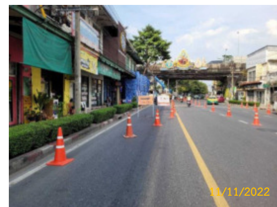
รูปที่ 2-31 การติดตั้งป้ายเตือน พร้อมทั้งไฟกระพริบและกรวย ที่ระยะ 20 เมตร
