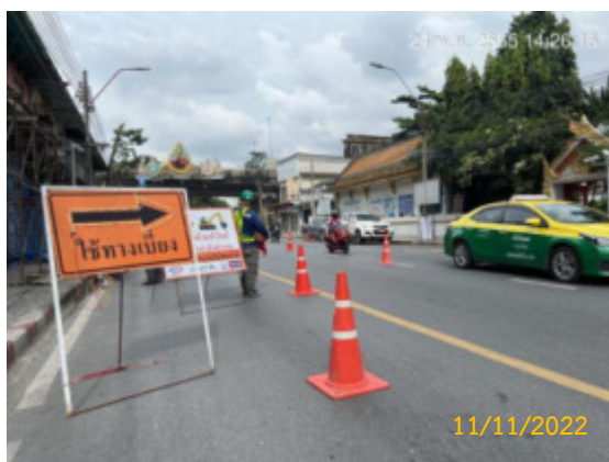
รูปที่ 2-31 การติดตั้งป้ายเตือน พร้อมทั้งไฟกระพริบและกรวย ที่ระยะ 20 เมตร
