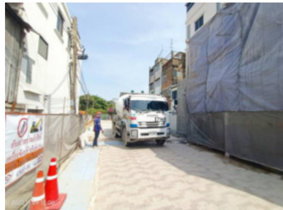
รูปที่ 2-16 การทำความสะอาดล้อรถไม่ผสมคอนกรีต ก่อนออกนอกโครงการ
