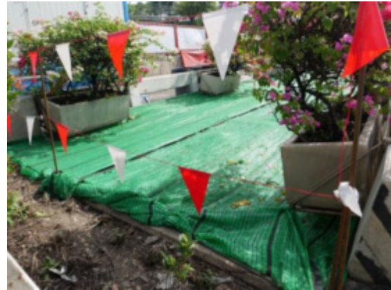
รูปที่ 2-19 การติดตั้งตาข่ายป้องกันขยและเศษวัสดุร่วงหล่นลงคลองสาธารณะ
