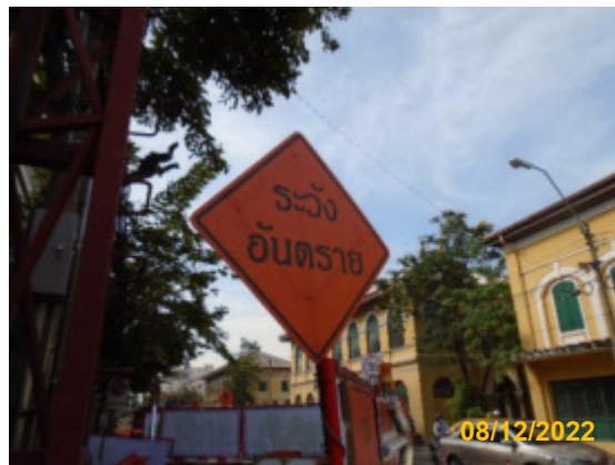
รูปที่ 2-24 การติดตั้งป้ายเตือนเขตพื้นที่ก่อสร้าง
