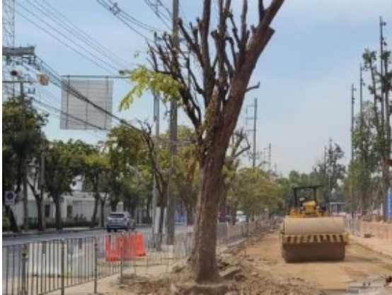
รูปที่ 2-9 การบดอัดชั้นดิน
