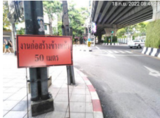
รูปที่ 2-28 การติดตั้งป้ายเตือนงานก่อสร้างก่อนถึง เขตพื้นที่ก่อสร้างที่ระยะ 50 เมตร
