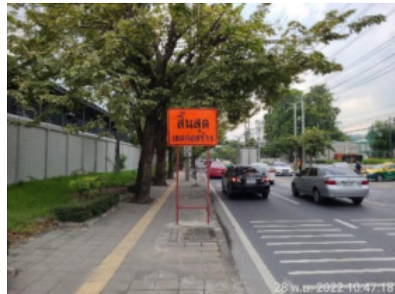
รูปที่ 2-30 การติดตั้งป้ายเตือนสิ้นสุดเขตพื้นที่ก่อสร้าง
