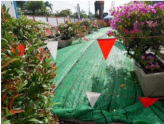
รูปที่ 2-19 การติดตั้งตาข่ายป้องกันขยและเศษวัสดุร่วงหล่นลงคลองสาธารณะ
