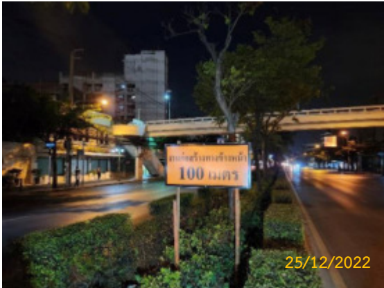
รูปที่ 2-27 การติดตั้งป้ายเตือนงานก่อสร้างก่อนถึง เขตพื้นที่ก่อสร้างที่ระยะ 100 เมตร
