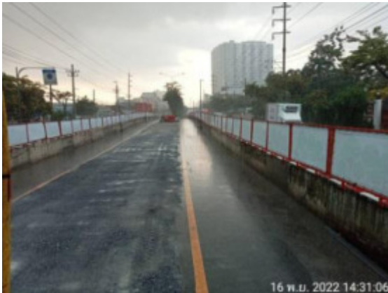
รูปที่ 2-11 การติดตั้งรั้วที่ความสูงอย่างน้อย 2 เมตร ตลอดแนวพื้นที่ก่อสร้าง
