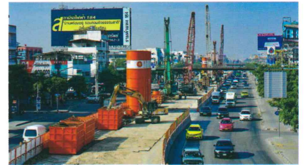
จัดวางแบริเออร์ตามแนวก่อสร้าง
