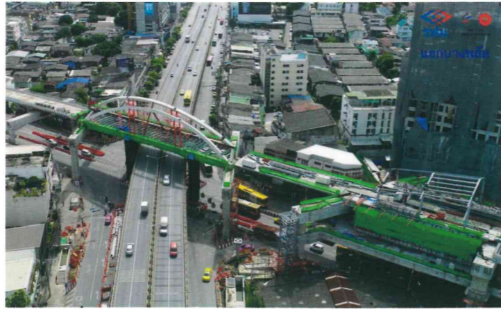
งานก่อสร้างโครงการระบบรถไฟฟ้าขนส่งมวลชน
